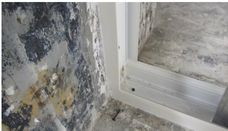
Aansluiting wand/vloer profiel
