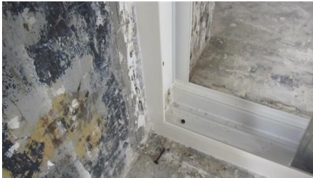
Aansluiting wand/vloer profiel
